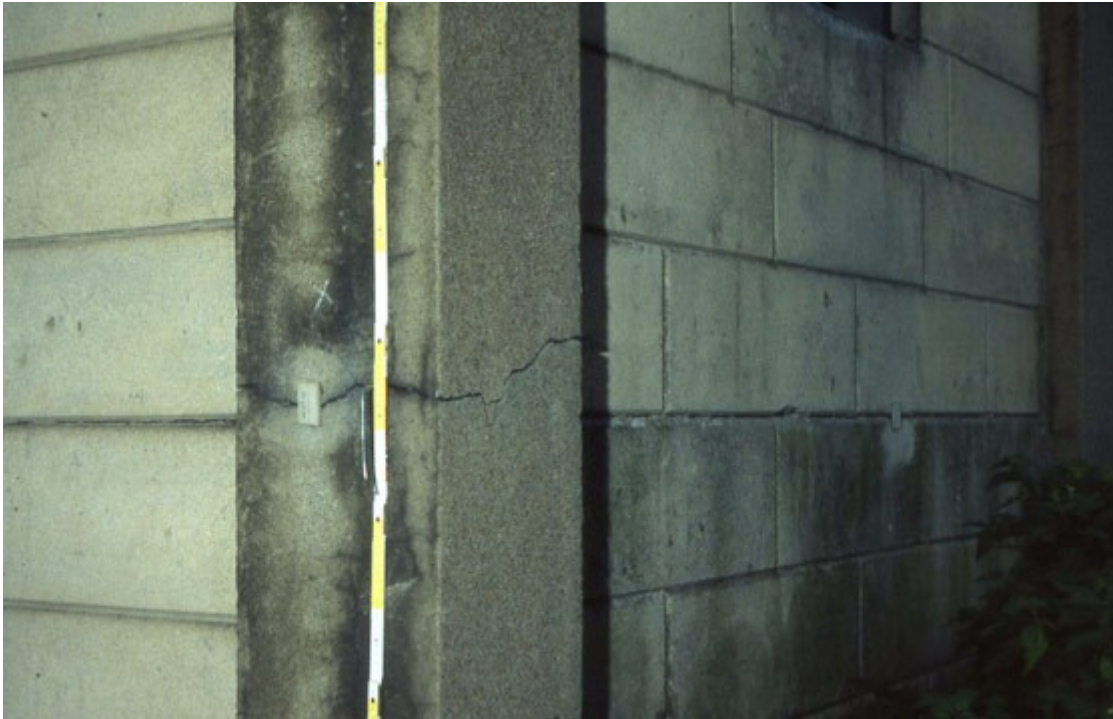
Abb. 28 Abriss in einer Stütze der Friedhofskapelle Jena-Göschwitz
