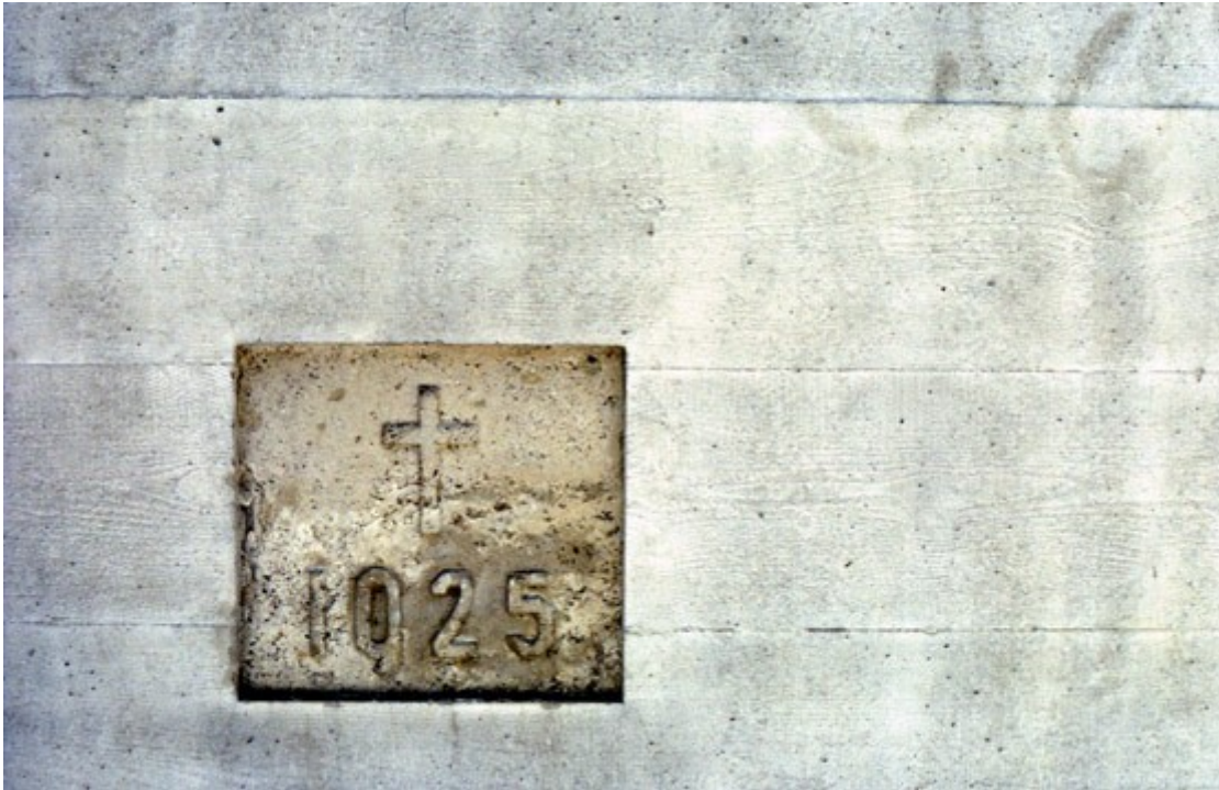
Abb. 21 Antoniuskirche Basel bauzeitlicher Beton mit Jahreszahl 1925, gerahmt vom Mehrauftrag des Reparaturbetons
