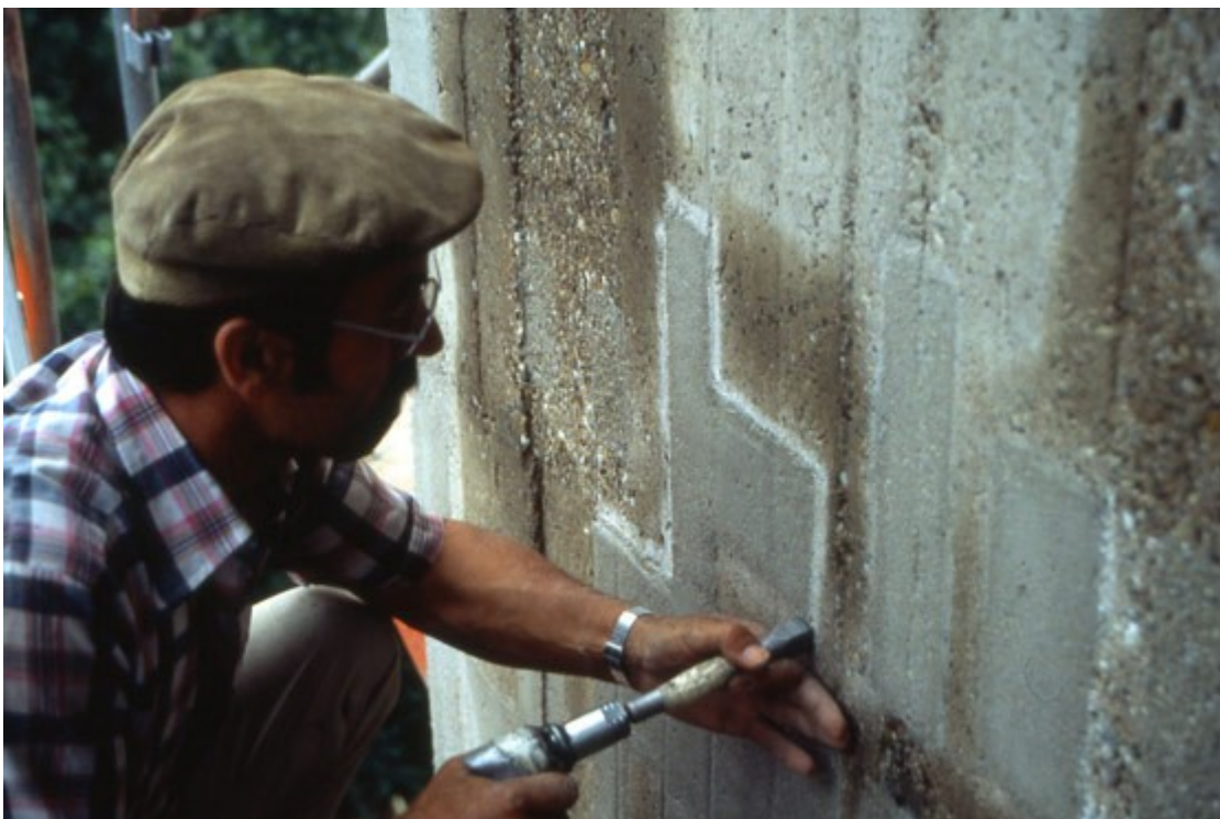
Abb. 29 Steinmetzmäßige Bearbeitung der Betonfläche nach dem Reprofilieren
