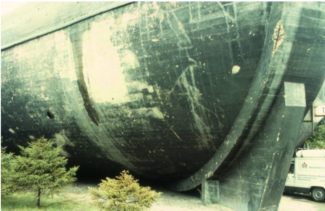
Abb. 27 Windkanal der Deutschen Versuchsanstalt für Luftfahrt Berlin, erbaut 1932 –
