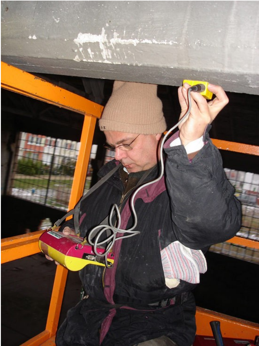
Abb. 15 Sondierung der Bewehrung mit dem Profometer
