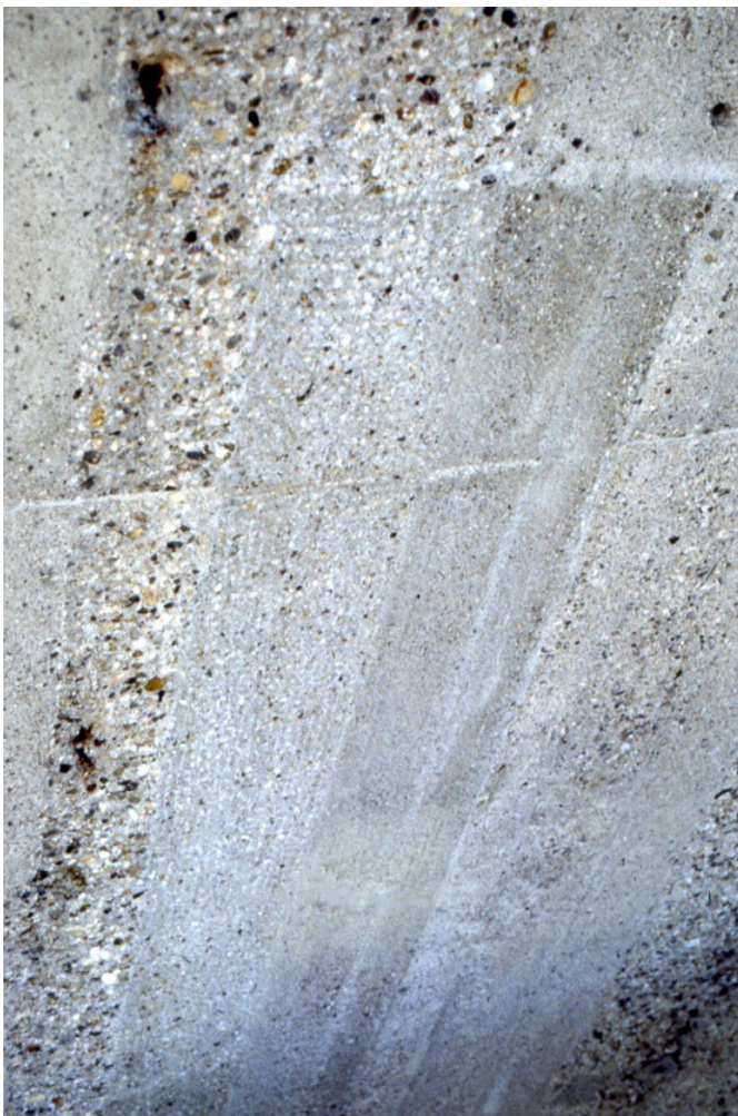
Abb. 33 Ergebnis der Reprofilierung im Detail
