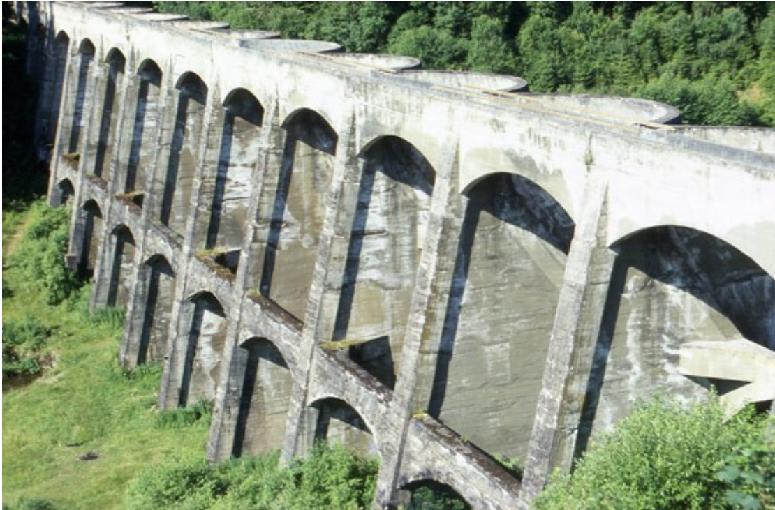
Abb. 44 Luftseite der Linachtalsperre Vöhrenbach
