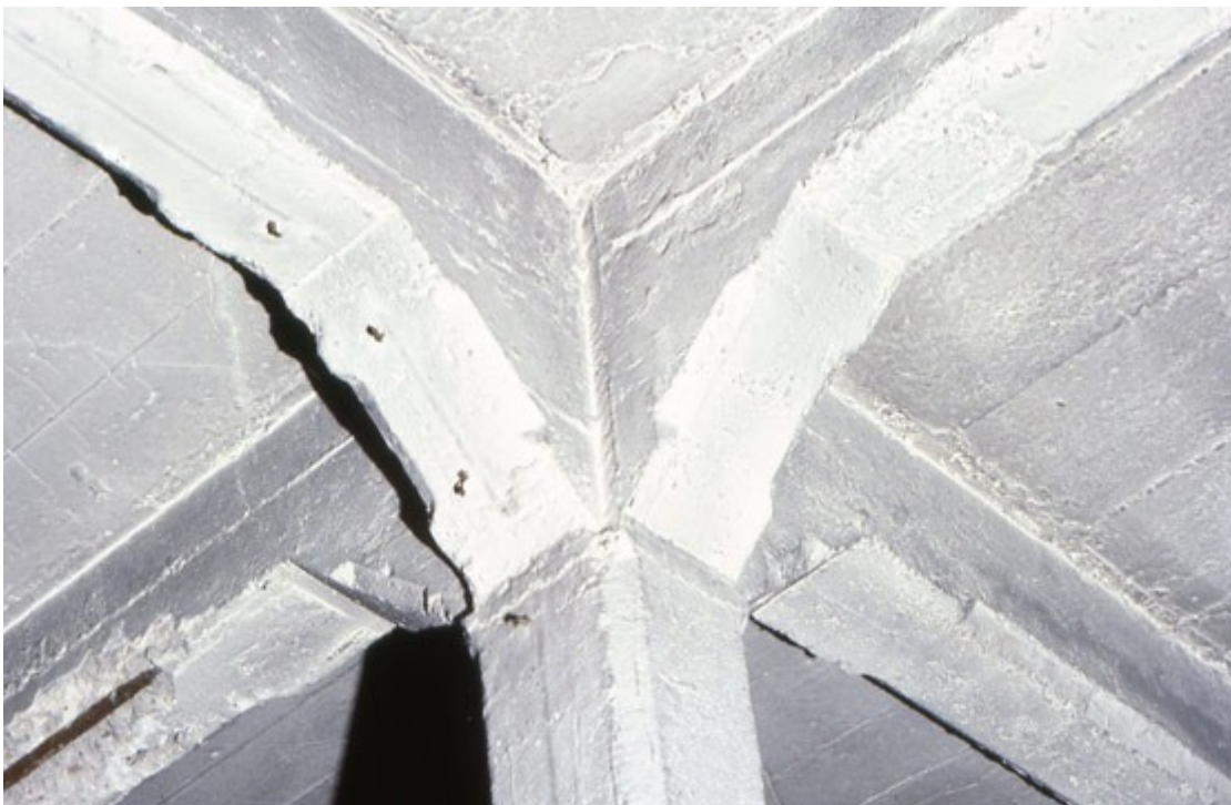
Abb. 35 Rechts oben im Bild Schalbrettabformungen ohne, links unten im Bild mit aufgelegtem Ölpapier (?)
