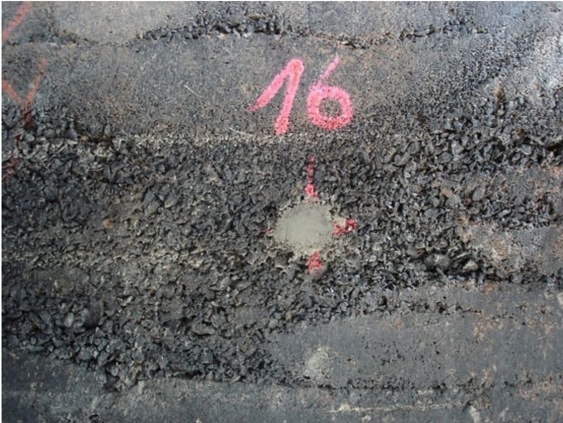
Abb. 9 Haufwerksporiger Beton in der Linachtalsperre Vöhrenbach
