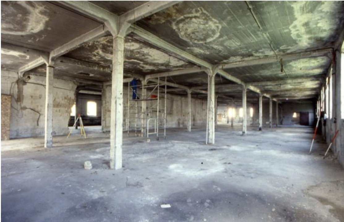
Abb. 3 Eisenbetonhalle in Osthofen, erbaut 1908
