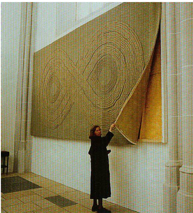
Bild 8 Mit Mineralwolle gefüllter Kasten hinter einem Wandteppich
